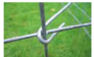
Etäisyystuki asetetaan niin että se menee hitsauksen ympärille.
