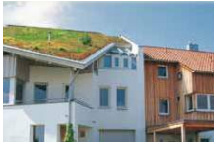
Tämä paritalo lähellä Tübingeniä, Saksassa, antaa kontrastia erityyppisten designien välillä. Puinen ja rapattu julkisivu, tiilikatto ja viherkatto.
