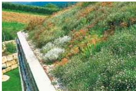
Jo yhden kasvukauden jälkeen peittävyys on lähes täysi. Tämän esimerkin kattoalue kuivatetaan ulkopuolella sijaitsevilla räystäskouruilla, joihin kolmet vesirännit kuljettavat ylimääräisen veden.
