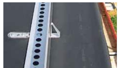
Irtokiinnitteisellä laipparakenteella, Shear Fix LF 300:sta ja Reunaprofiili TRP 80:stä, leikkausesteet voidaan myös toteuttaa viherkattoalueen sisällä.
