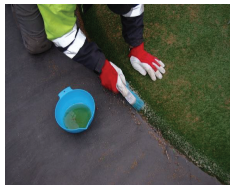
3. Valmistelee reuna-alueet. Jos turva-alusta yhdistetään johonkin pintaan, tulee se käsitellä ensin kiinniteaineella tartuntapinnaksi.
