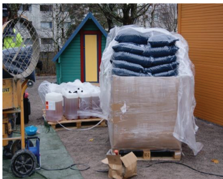
1. Tarkista että kaikki tarvittavat materiaalit ja tarvikkeet ovat paikalla. Tarkista että pohja on valmis asennuksen aloittamiselle.
