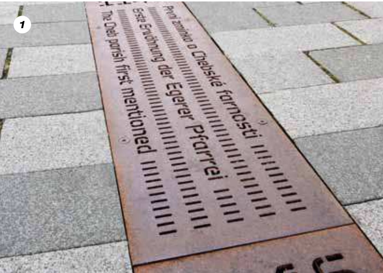
1 Jalankulkualue, Tšekin tasavalta Jalankulkualan kuivatukseen Chebissä (Tšekin tasavalta) KE-100 järjestelmällä, Ronn Drain yritys valmistutti erikoisritilöitä, jotka samanaikaisesti kuivattaa sadevettä ja esittelevät kävijöille kau- pungin historiaa.
