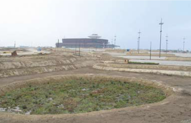
Haihdutusalas Malmö Arena
